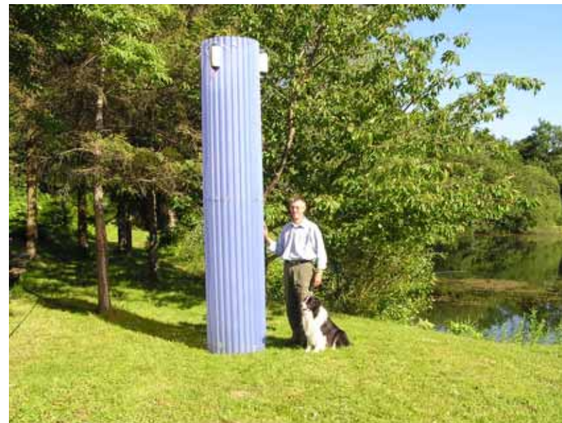
Skorstensdiffusoren fremstilles af to trapez tagplader, der skrues sammen til et rør, og hænges i en bøjle midt i søen.
